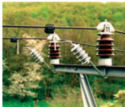
от сети. CLX устанавливается рядом с опорным изолятором и может быть подстроена под существующую линию. Определенный искровой промежуток выставляется с помощью кронштейна, электрода и линейного зажима.
